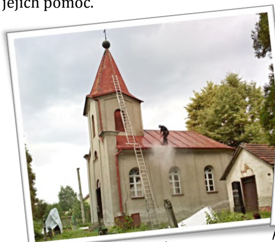
Kaple před rekonstrukcí
